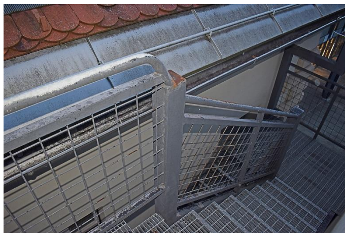
Slika 6: Kredanje, neustrezne debeline na ograji stopnišča
